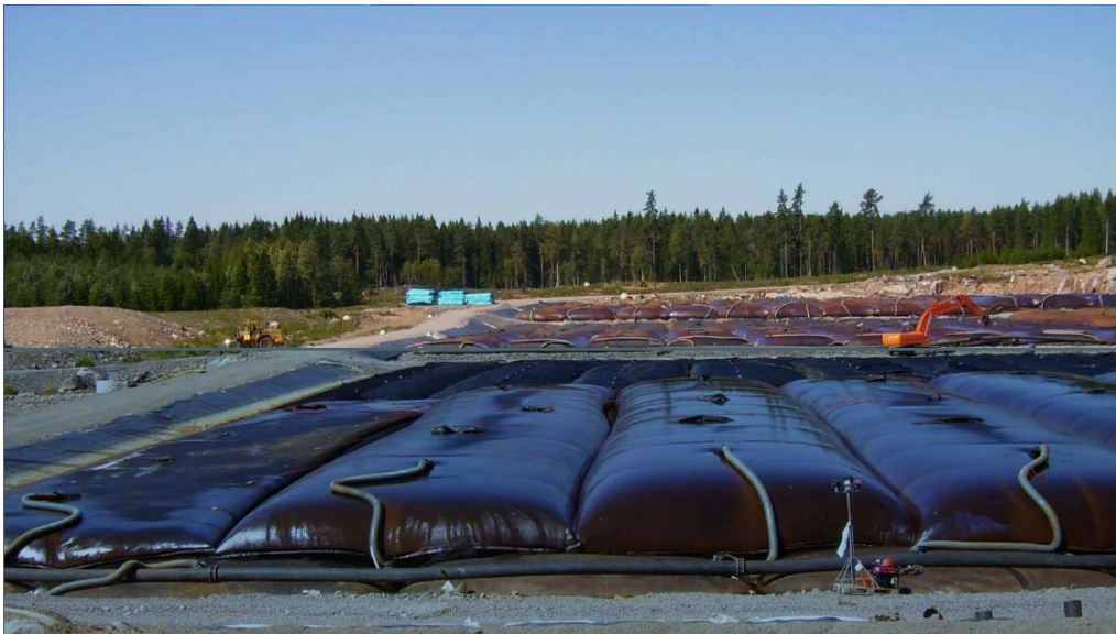
Figur 8. Bild på geotuber från saneringen av Svartsjöarna.
