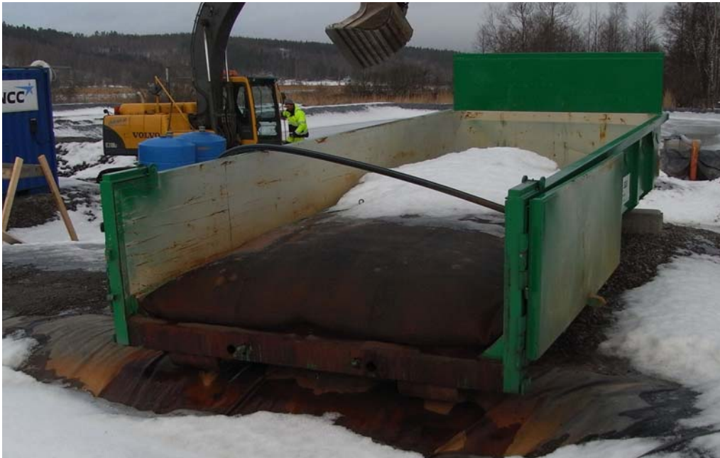
Figur 11. Geotub i lastväxlarflak vintertid, Bohus varv
