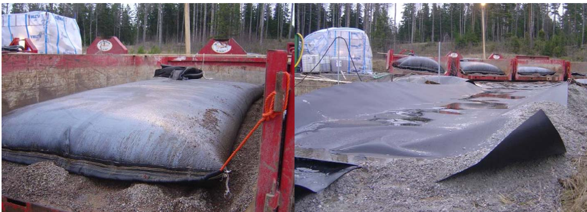
Figur 10. Avvattning av slam från lakvattenrening med geotuber (Milman Miljömuddring)
