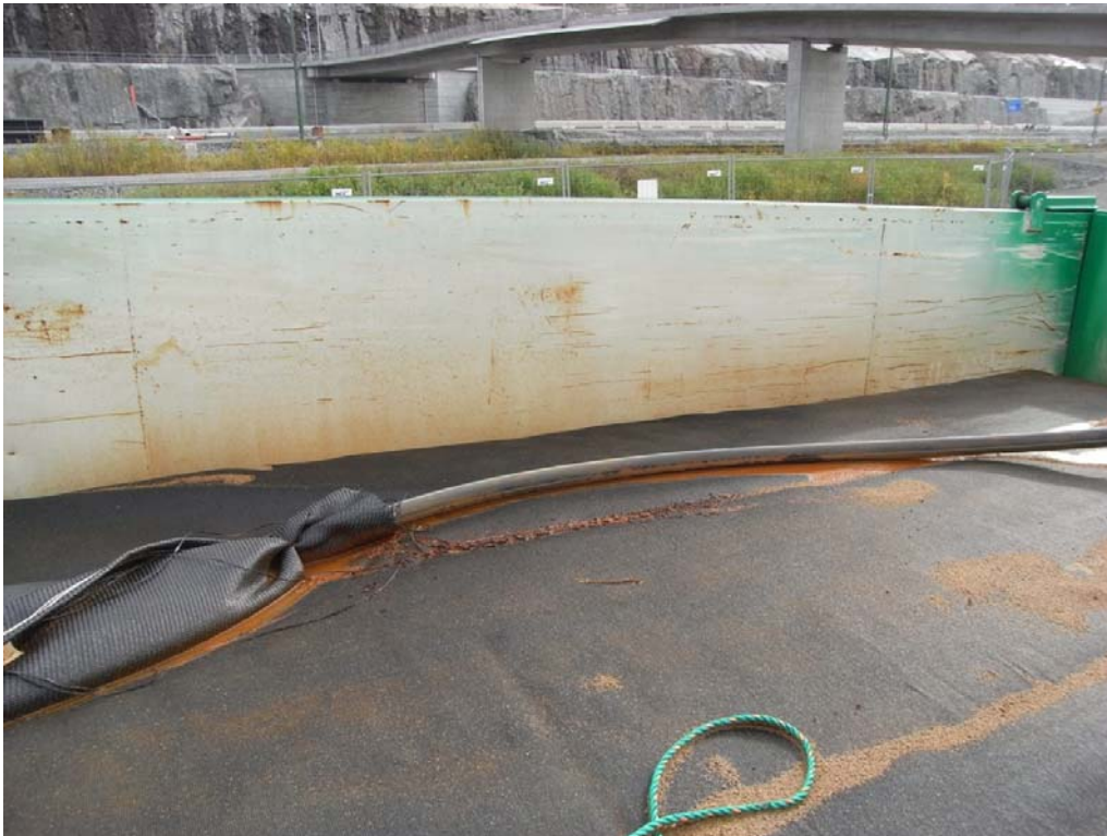
Figur 20. Exempel på för låg polymerhalt. Rödfärgat slam tränger ut genom geotuben.
